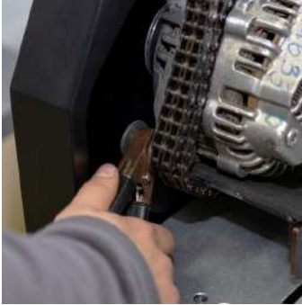
Рисунок 18. Підключення силових кабелів до генератора
